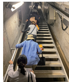
ダム内部②
